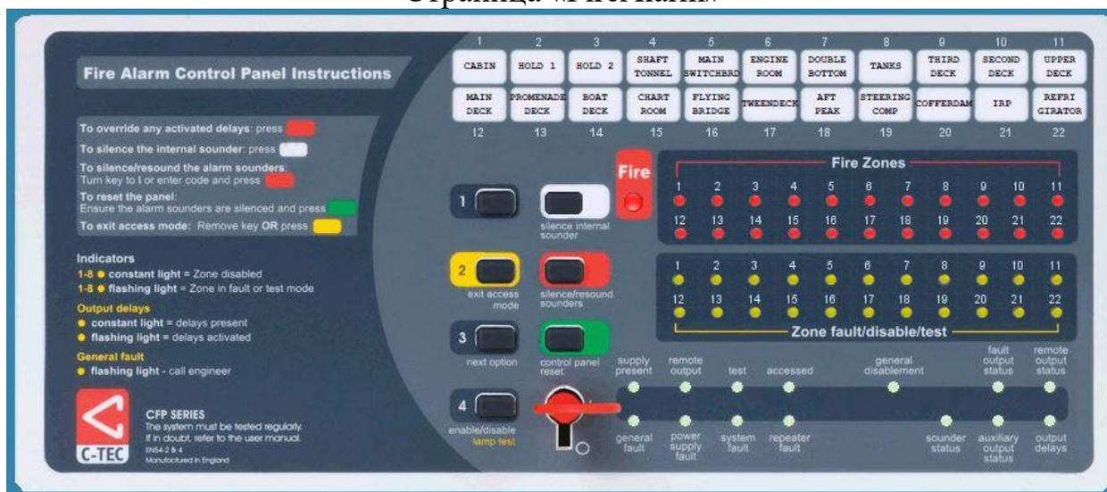
На данной странице мы можем наблюдать панель пожарной сигнализации, которая предназначена для мониторинга пожарной ситуации на судне.
